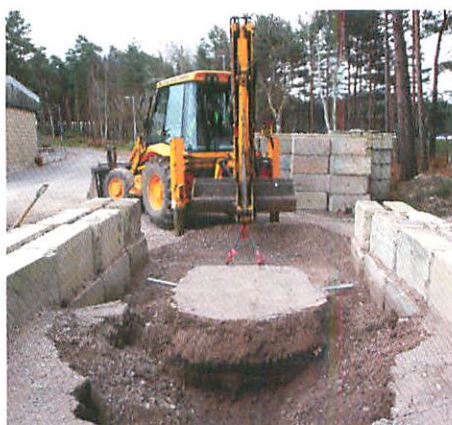
Valutazione del danno dell'installazione di TriAx nello scavo
