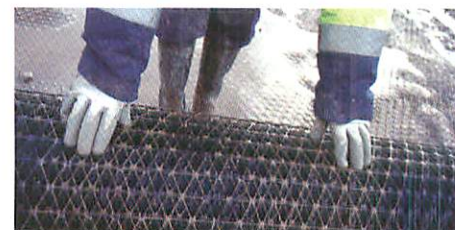
La geogriglia viene srotolata in cantiere
