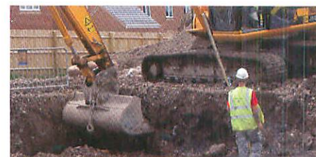
L'aggregato viene posto sulla geogriglia TriAx prima della compattazione
