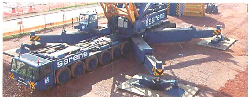
Pesanti gru su una piattaforma di lavoro stabilizzata con geogriglie Tensar
