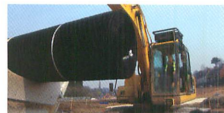
La geogriglia TriAx può essere facilmente trasportata con un macchinario adatto alla posa o da due persone
