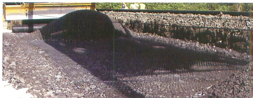
I benefici del suolo stabilizzato con Tensar sulla massicciata ferroviaria
