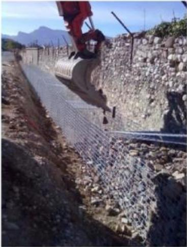
**Esempio configurazione pannelli per gabbione m 2,00x1,00x1,00**
