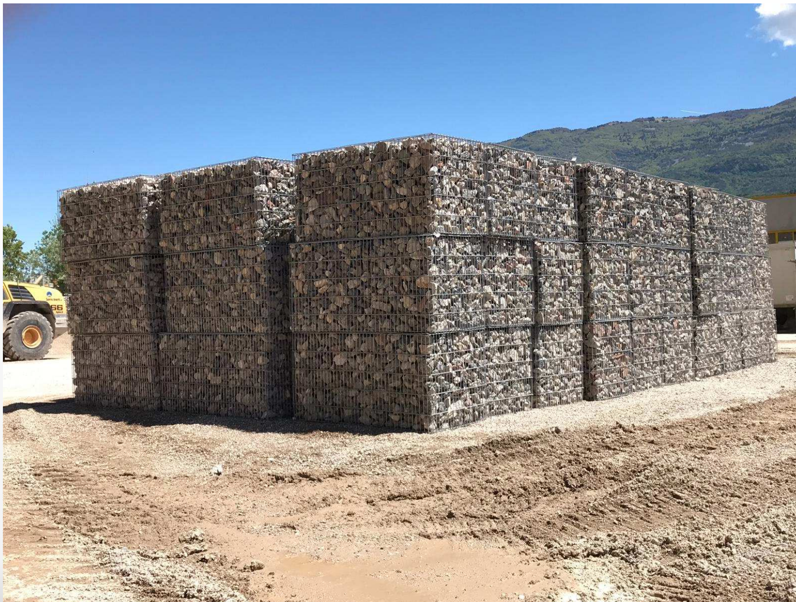
Marchatura CE di gabbioni strutturali in rete elettrosaldata e parametri fondamentali per la redazione del calcolo statico in reazione al Regolamento Europeo 305/2011 ed al DM 17/01/2018. Esempi di utilizzo in ambito strutturale, architettonico e di arredo urbano – Ordine Geologi Liguria – Ordine Ingegneri Provincia Imperia - 23/11/2022 – ing. Simone Graffer
